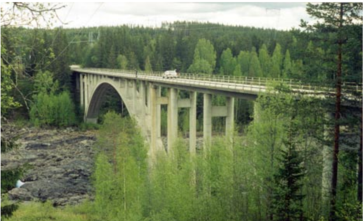
Bron över den torrlagda Ljusnan vid Laforsen
