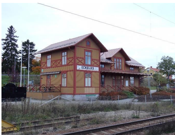
Stationshuset sett från plattformen.
