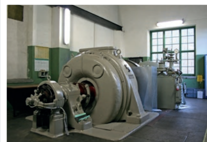
Turbin uppställd i maskinhallen, Mellby kraftstation, Kalmar län.
