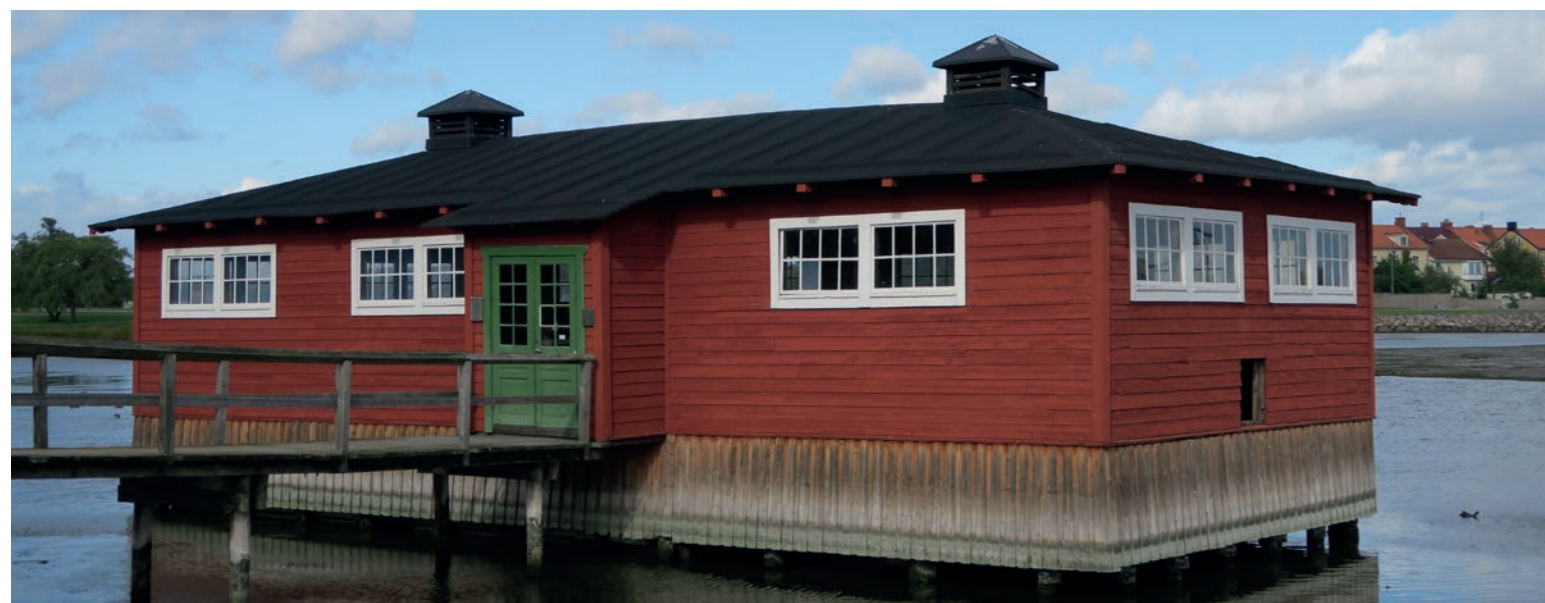
▲ Klapphus i Kalmar, från början på 1900-talet, numera byggnadsminne. Här kunde tvätten sköljas och klappas i skydd för väder och vind. Foto: Richard Edlund
