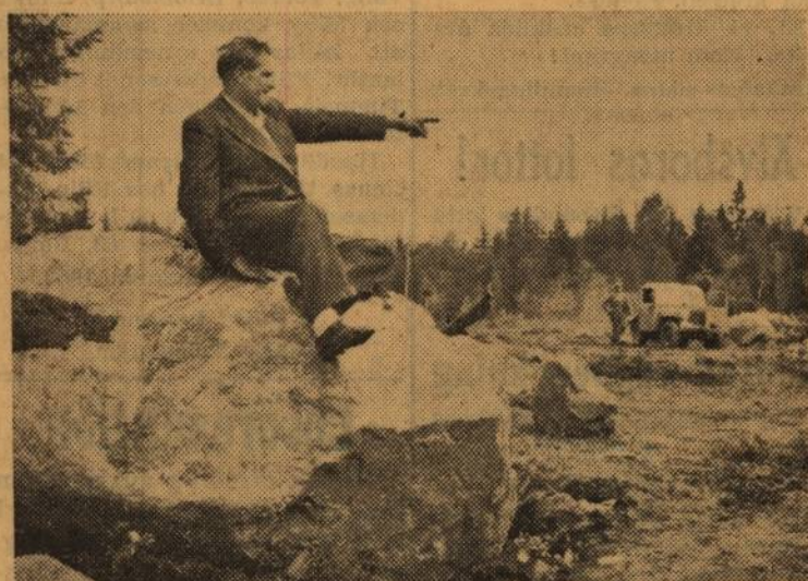
Vegbys SK:s ordf. Knut Sandell, visar området för den nya idrottsplatsen. Som framgår av bilden är det inte enbart småsten som måste bort innan det verkliga planeringsarbetet kan påbörjas.
