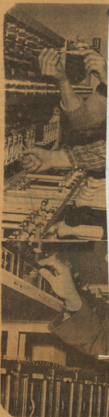
Ett bildsvep från monteringsarbetet på det nya ställverket vid Borås Central. Överst arbetare Ake Johansson och Arne Axelsson med avsyning och på bilden därunder visar signaleringen för F. Ekberg några av de 507 relederna i källarvåningen.
