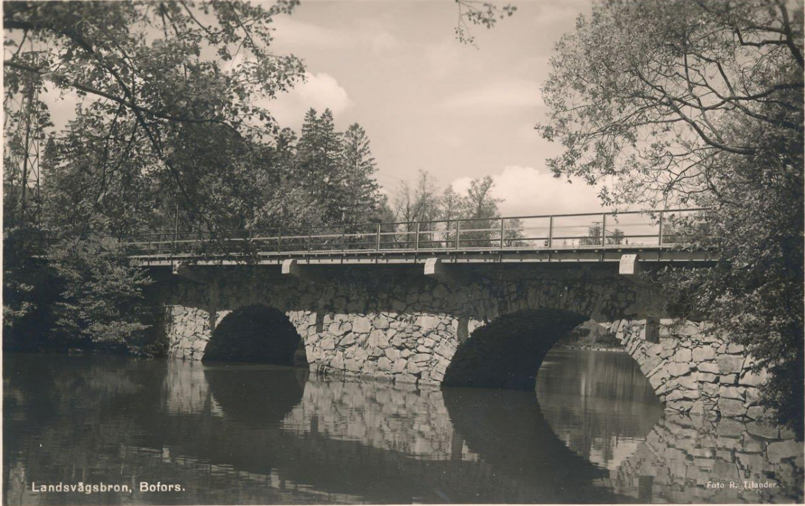
Stenvalvsbron som är rivet (L1981:6754).
