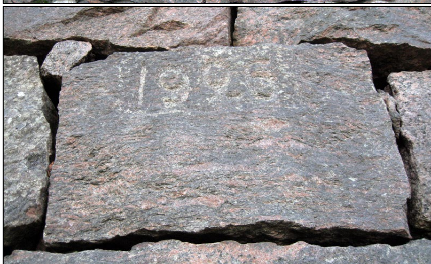
Detaljer av dammvallen.
