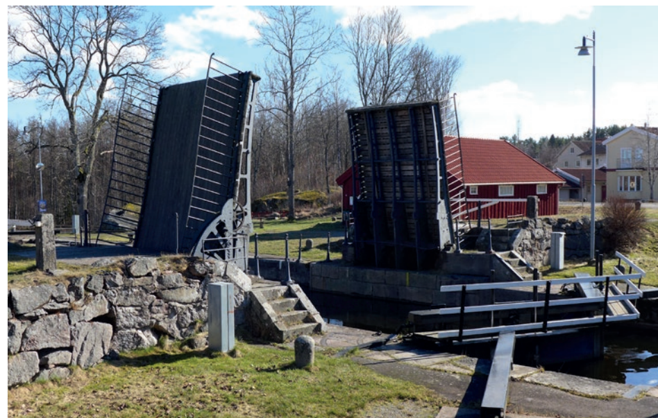
▲ Sveriges äldsta gjutjärnsbro tillverkad vid Stafsjö Bruk 1813. Bron går över Göta Kanal vid slussen i Forsvik, Västra Götalands län. Foto: Lena Ljungberg och Thomas Carlquist
