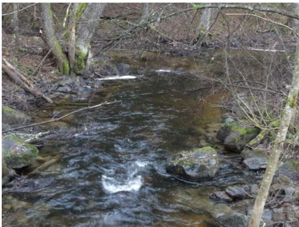
Figur 5. På bilden ser man hur strandkanten uppe till vänster är förstärkt genom enkelkistor i Älgån. Foto från S. Fotografi av Ellinor Forssell, Kulturmiljöcentrum Värmland.
