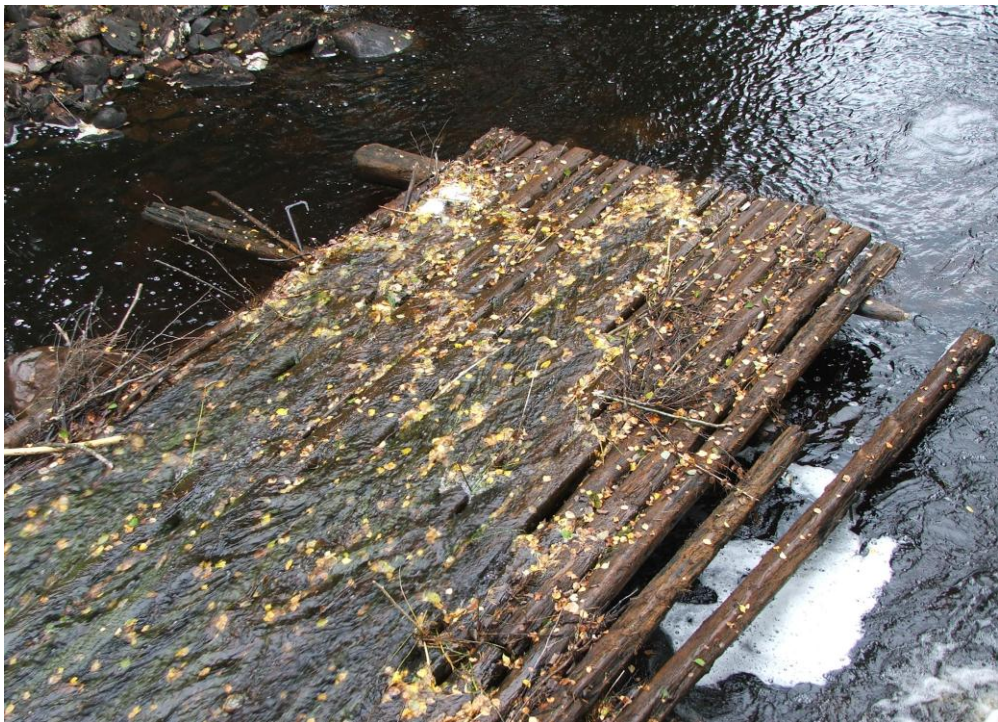
Figur 4. Stöttbotten i anslutning till damm (Obj 49).
