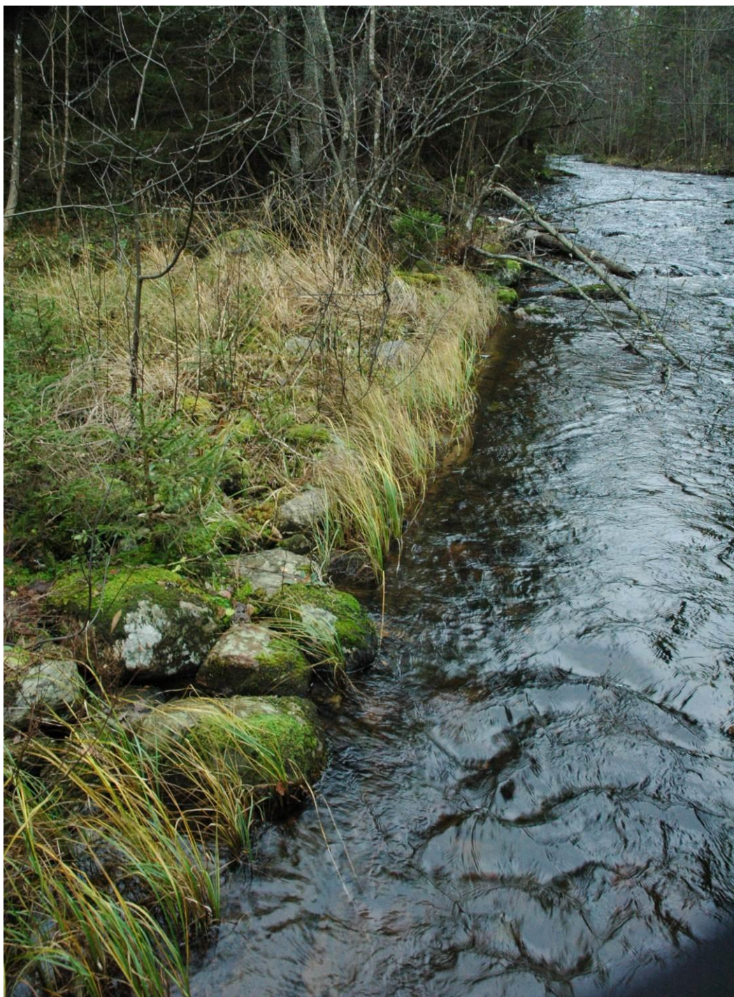
Figur 15. Ledarm, objekt46. fylld med sten, där synliga delar av fackverket skymtar fram i nedre bild och under
