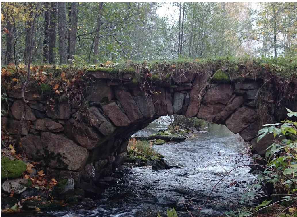
Figur 22. Objekt 86, stenvalvsbro mellan Högen och Slirud, fotograferad från syd.
