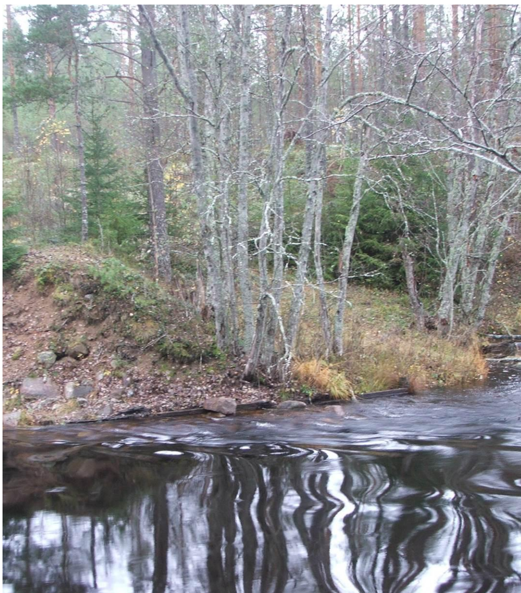
Figur 43. Flottningsdammen (Obj 2 och 5) vid Nedre Ingervadssjön med synliga delar av kar nedom dammvallen. Foto från nordväst.
