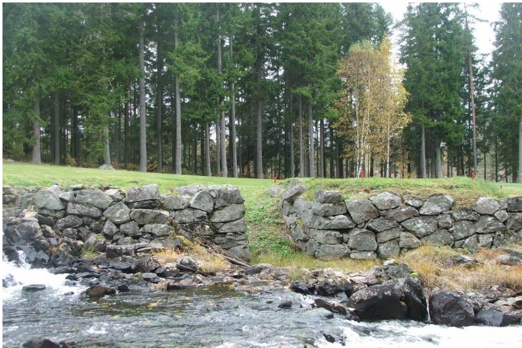
Figur 6. RAÅ 144:1 vilken endast omnämns som grundmurar men som i själva verket utgör lämningar efter en såg med tillhörande dammvall (Obj. 50). I älven och hitom fundamenten är en stenkista (Obj. 27). Foto från syd.
