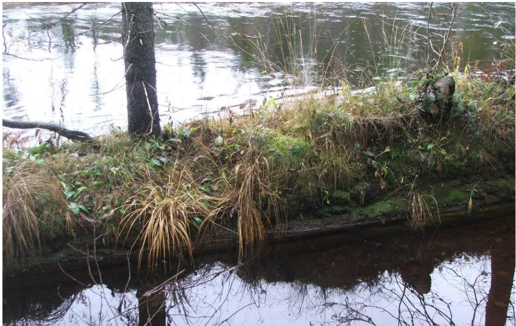
Figur 44. Obj. 16. Överväxt ledarm i form av dubbelkista vilken är fylld med sand med synliga stockvarv i vattenlinjen. Foto från väst.
