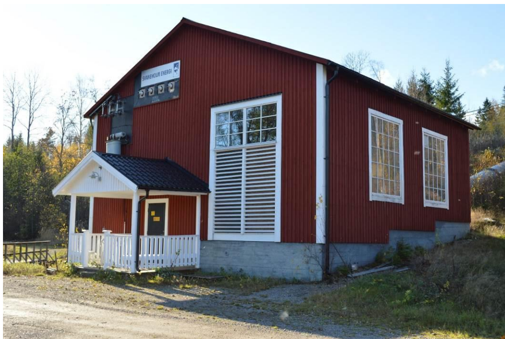
Figur 29. Kraftstationen vid Näs.
