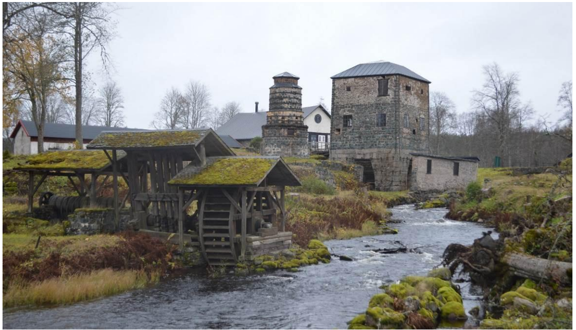
Figur 11. Hyttanläggningen med masugn och rostugn samt ruinen efter rådstugan som omger masugnen. Vattenhjulet invid slaggstampen rekonstruerades av en modellsnickare i Filipstad runt 1980.
