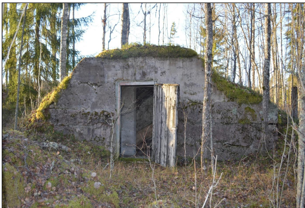
Figur 41. Jordkällare i betong.
