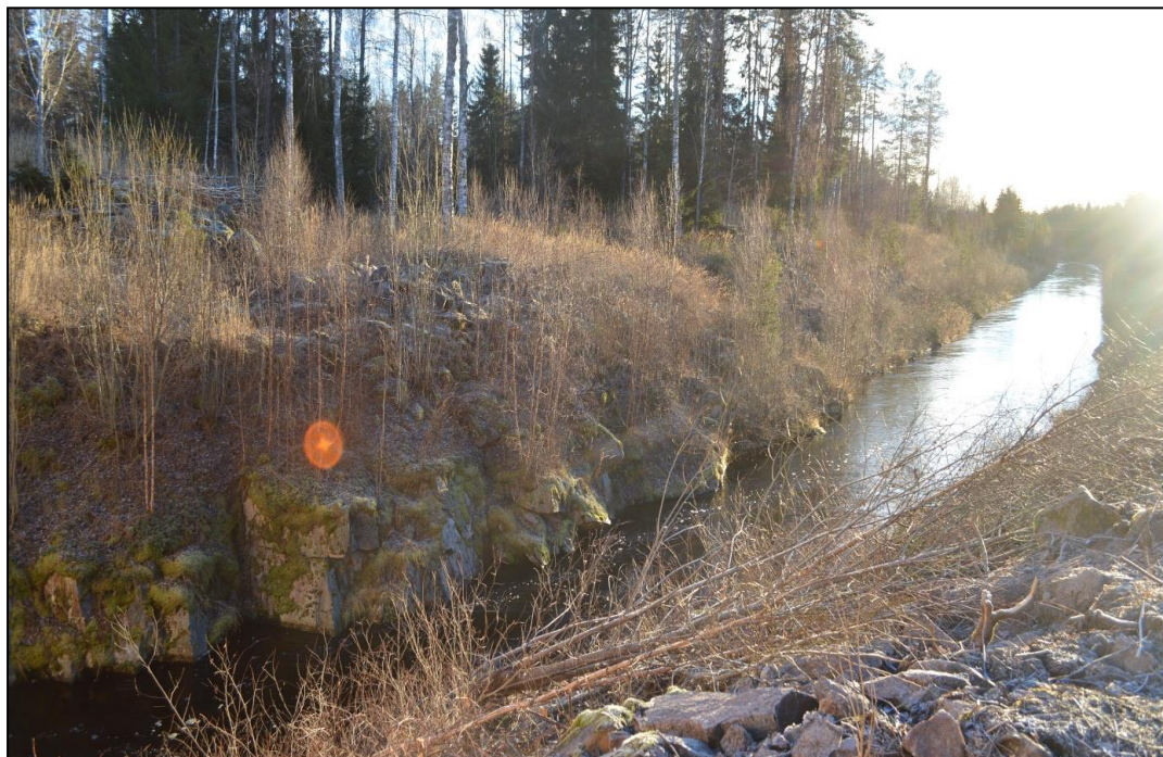
Figur 48. Efter kraftstationen följer en grävd kanal som leder vatten vidare till sjön Knon från vilken Knon kraftstation får sitt vatten.
