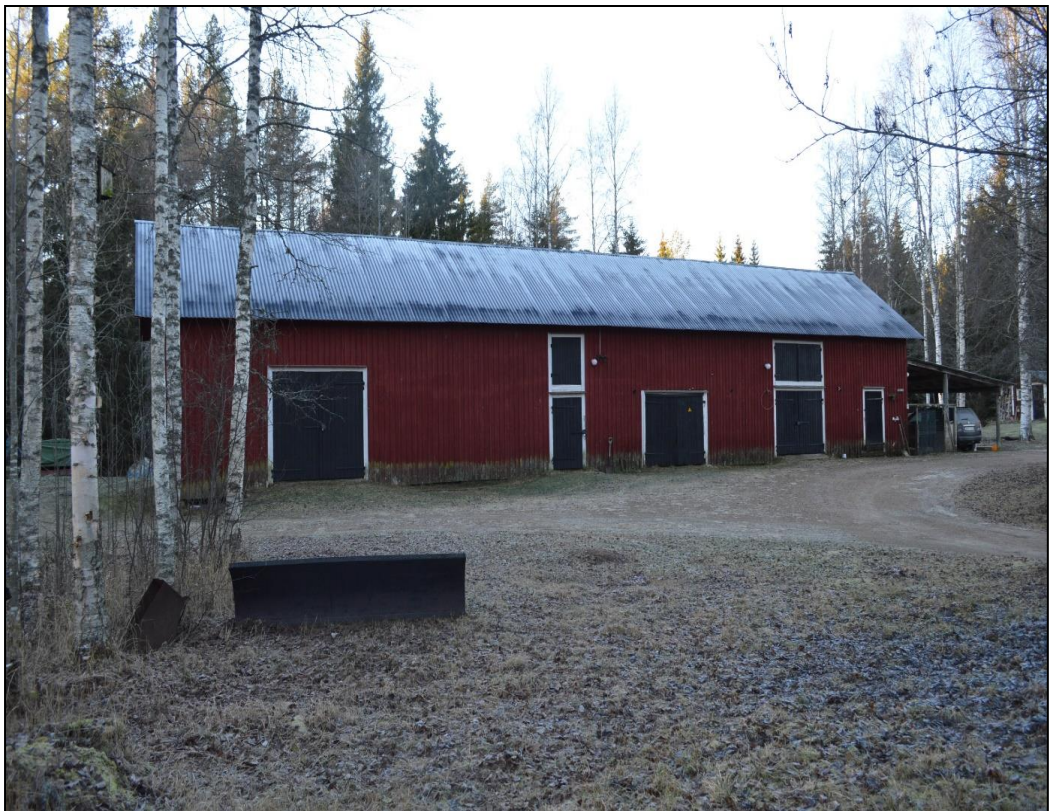
Figur 49 Ett stenkast från Nains kraftstation ligger gården Valla (Obj. 5), med anor från tidigt 1800-tal. I närheten uppfördes i samband att kraftstationen uppfördes ett trefamiljshus för maskinisterna, som gick skift på kraftstationen. Detta hus brann ner i samband med den stora skogsbranden 1933, men ett nytt hus uppfördes. Detta revs enligt uppgift på 1970-talet. Vi det laget hade fjärrstyrning av stationen införts.
