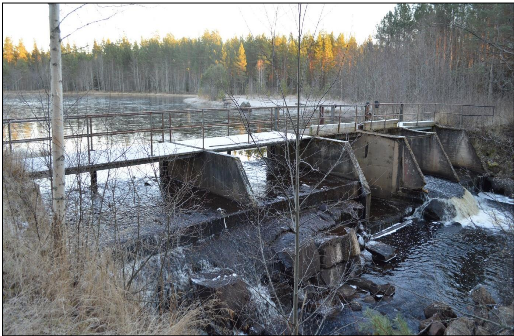
Figur 51. Strax öster om Gustavsfors finns denna damm (Obj. 6). Enligt uppgift byggdes den om runt 1970. Dammen användes i flottningen. Utanför bild, till vänster om dammen börjar en kanal som ledde fram till hyttan, tackjärnsmasugnen i byn, för att driva de mekaniska verk som fanns däri.
