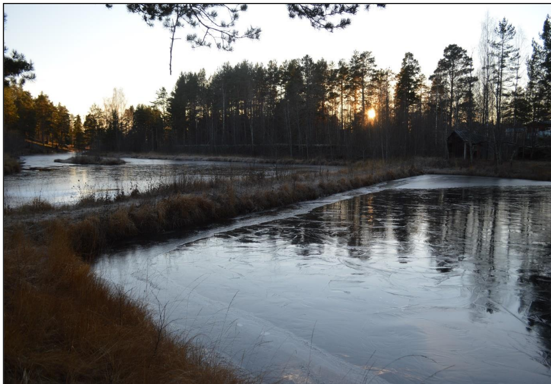
Figur 54. Nedanför hyttområdet finns en smal landremsa, en vall, som är en rest efter flottningen. Vallen utgörs av slaggsten som lades här för att förhindra att timmerstockarna kom fel och samlade sig vid hyttan.
