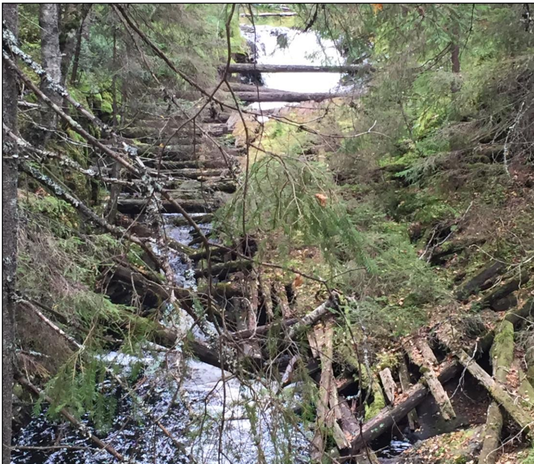
Figur 61. Flottningsränna/stötbotten (Obj 63). Foto från norr. Foto: Ellinor Forssell, Värmlands Museum.
