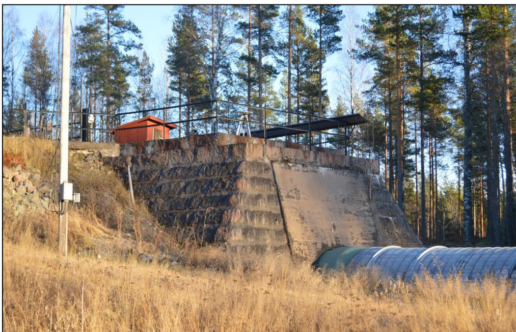
Figur 45. Konstruktionen i tuktad sten visar prov på det tidiga 1900-talets byggnadskonst.
