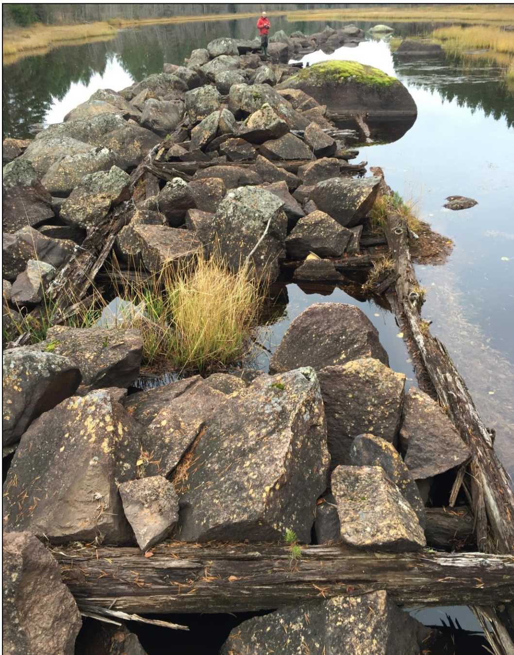
Figur 34. Dubbelkista (Obj. 69) med en senare anlagd förstärkning i form av en stenvall vilken är placerad mot dubbelkistan. Dubbelkistans fackverk framträder tydligt och det stora antalet bettingar skymtar fram mellan stenarna. Foto från norr. Foto: Ellinor Forssell, Värmlands Museum.
