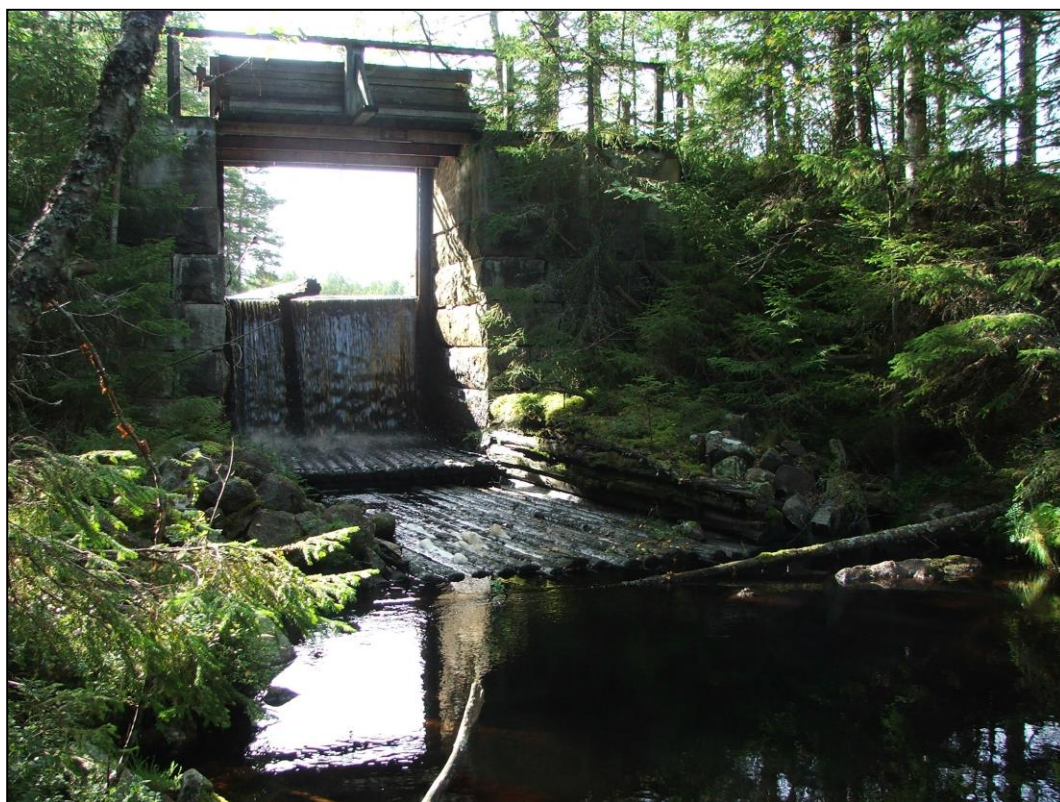
Figur 19 . Flottningsdamm med stötbotten/skibord vilken flankeras av dubbelkistor (Obj 1-3). Foto från norr. Foto: Ellinor Forssell, Värmlands Museum.
