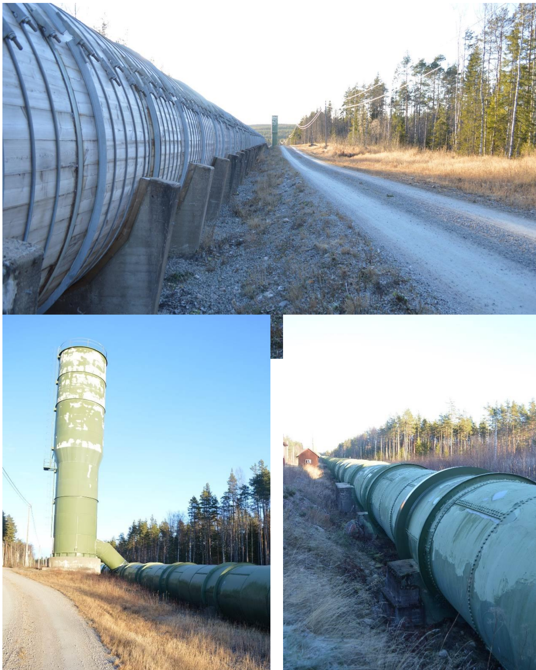
Figur 46. Den långa trätuben övergår i en ståltub sista biten ner till kraftstationen. Tornet på nedre bilden till vänster kom enligt uppgift till 1944. Det är ett svaltorn som ska minska trycket i tuben i händelse av driftstopp. Tornet är 28 meter högt.
