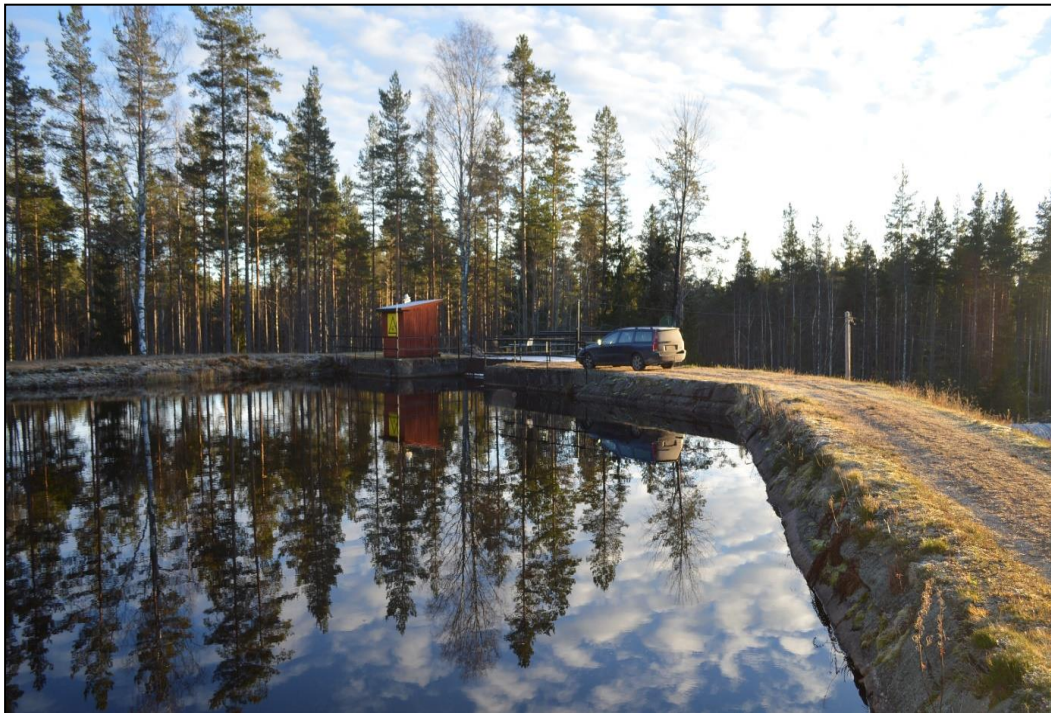
Figur 44. Bilden visar vattenmagasinet (Obj. 3) ovanför Nains kraftstation. Härifrån leds vattnet vidare via en 870 meter lång tub ner till kraftstationen. Uvån går parallellt en bit in i skogen.
