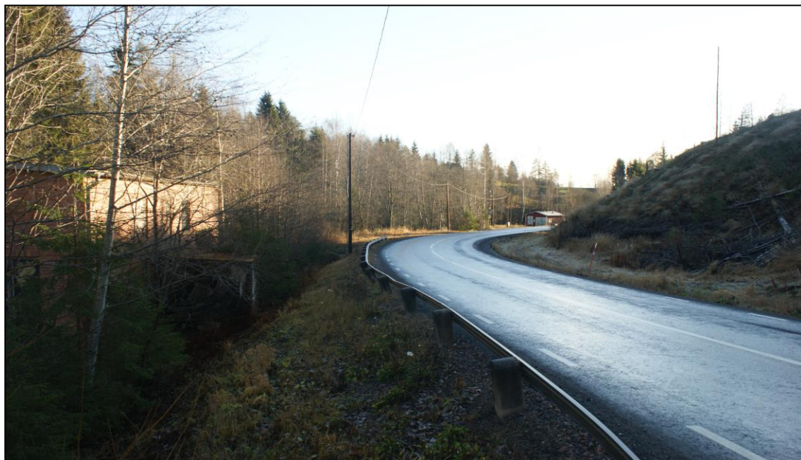
Figur 15. Kraftstationen till vänster i bild. Längre ned längs vägen finns ytterligare två byggnader som använts
