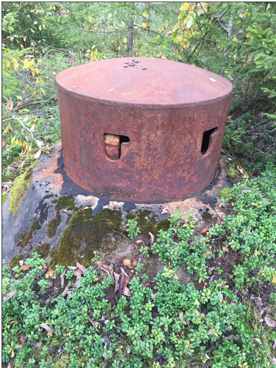
Figur 6. Skyttetorn i järn på toppen av en betongbunker (Obj. 33). Foto från väster. Foto: Björn Wallbom, Värmlands Museum.
