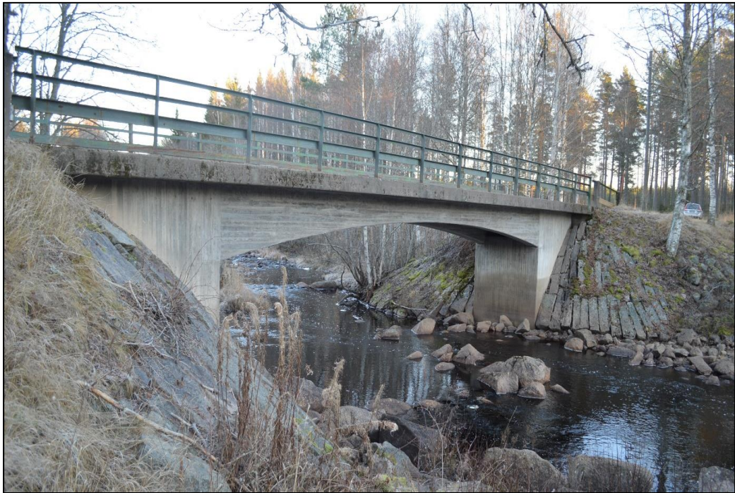
Figur 52. Strax intill hyttområdet i Gustavsfors finns denna balkrambro (Obj. 7), med erosionsskydd i natursten på vardera sida om brofästena. Typen av bro och räcken, grönmålade vinkeljärn och navföljare i form av en U-balk, är typisk för perioden 1930- till 1950-tal.
