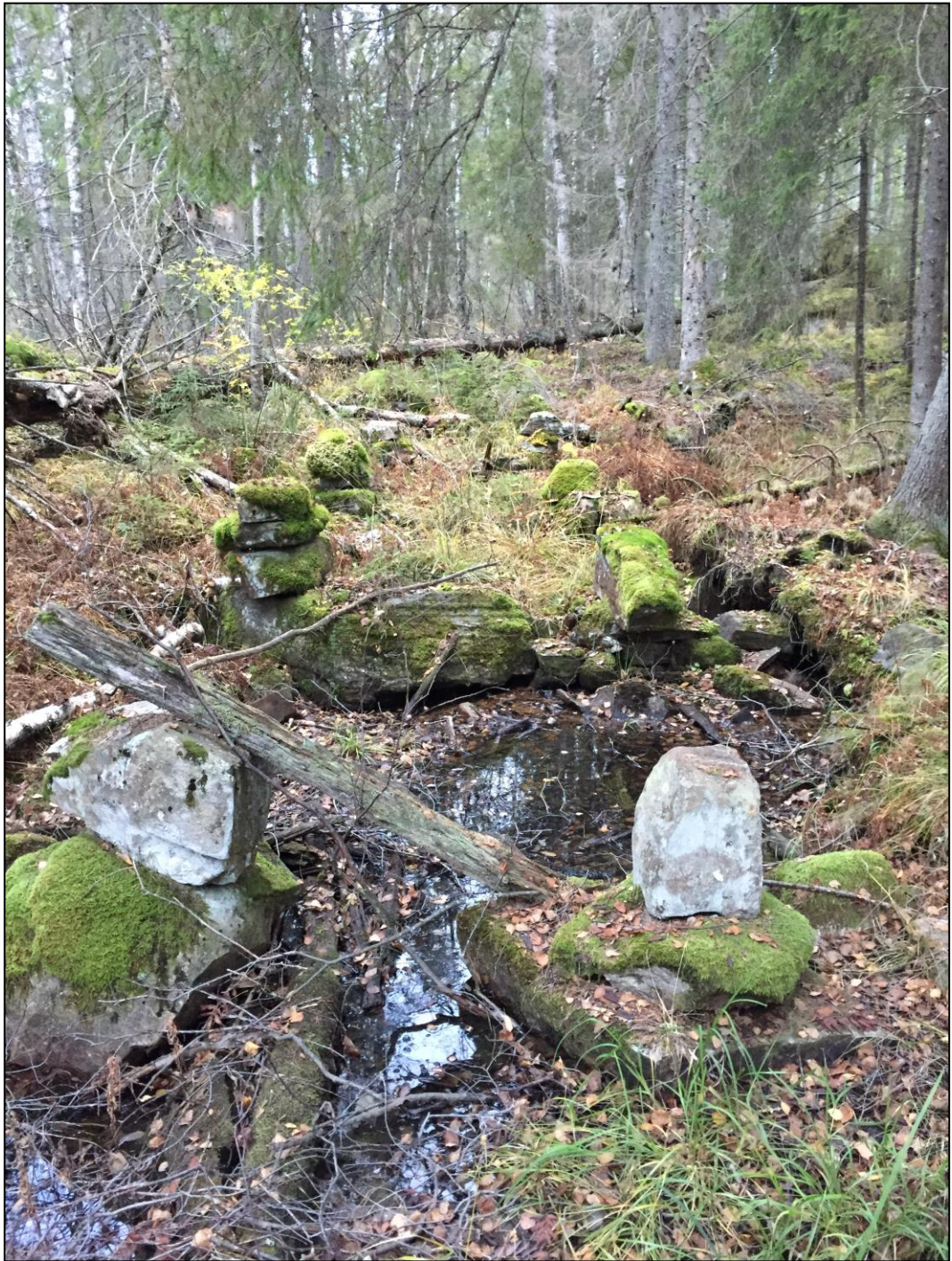
Figur 76. Parallella stenfundament till flötningsränna (Obj. 5). Foto från söder. Foto: Björn Wallbom, Värmlands Museum.
