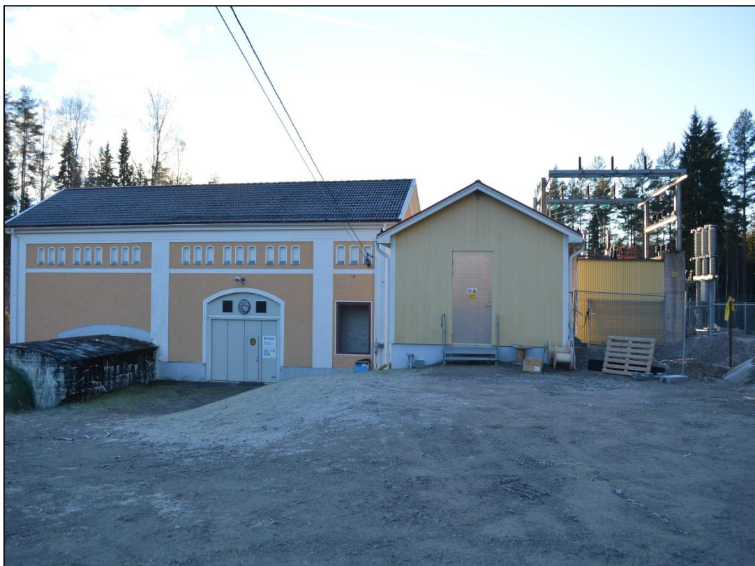
Figur 47. År 1914 tecknade Uddeholm ett avtal med Staten om vattenrätten i Uvån. Därefter kunde anläggandet av kraftstationerna Nain och Knon (Gustafsfor) påbörjas. Bilden ovan visar Nains kraftstation (Obj. 4), drifttagen 1916. En större ombyggnad skedde 1944 då ny utrustning installerades.
