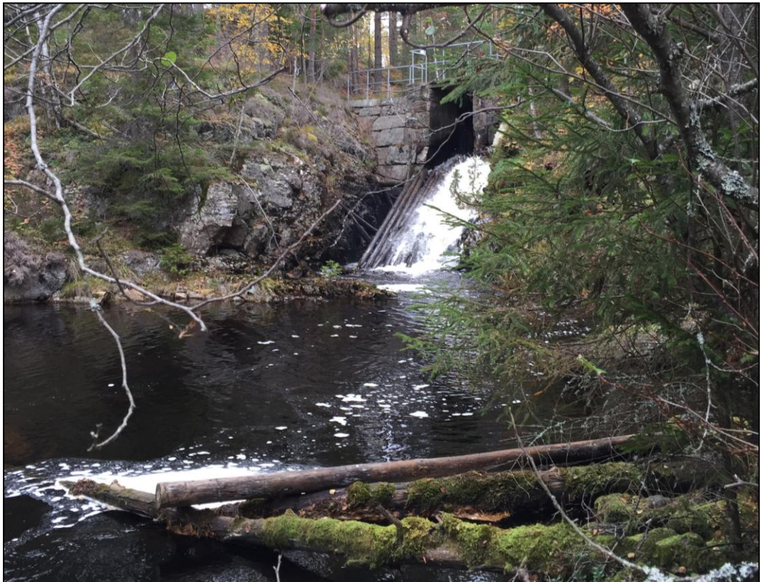
Figur 67. Flottningsdamm med stötbotten intill ett av utskoven. Foto från nordväst. Foto: Ellinor Forssell, Värmlands Museum.
