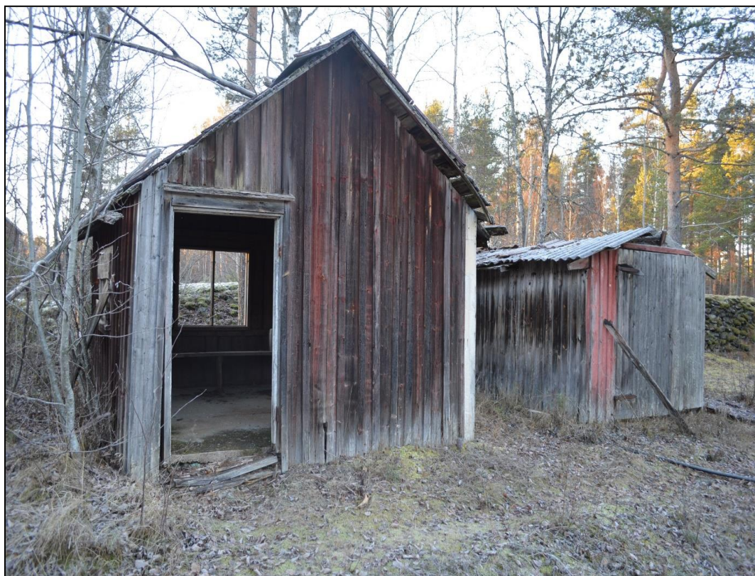
Figur 55. På andra sidan om landremsan ligger två förfallna träbyggnader som tidigare utgjort tvättstugor för byns befolkning (Obj 8).
