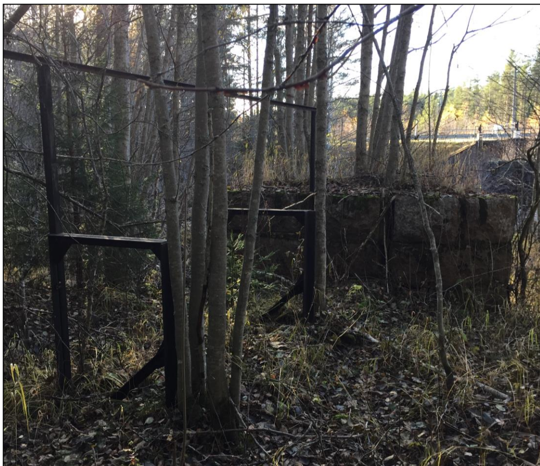
Figur 39. Delar av fackverk för plankor tillhörande nåldammen (Obj. 23). Foto från öst. Foto: Ellinor Forssell, Värmlands Museum.
