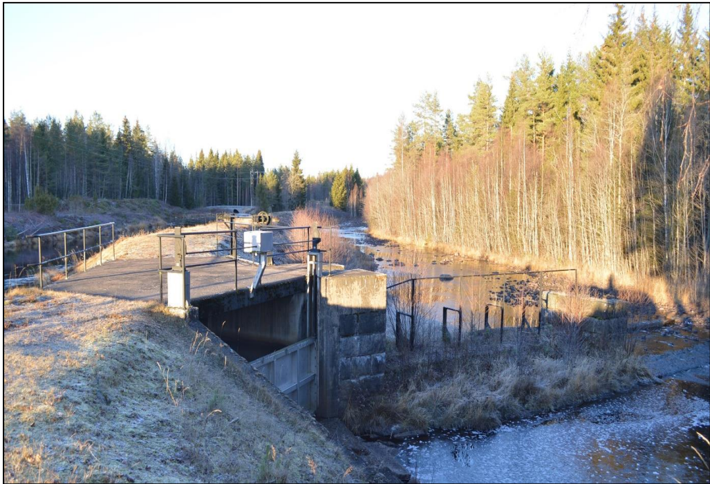
Figur 50. En bit nedströms från Nains kraftstation löper kanalen och Uvån parallellt. Platsen är på FMIS karta redovisad som Nåldammen. Här finns en lucka som möjliggör avtappning från kanalen och även rester efter själva nåldammen i Uvån. Dammen nyttjades i flottningen.
