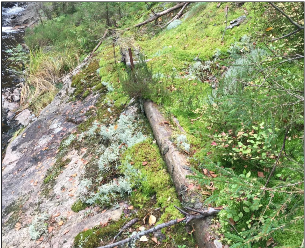
Figur 66. Spänger fastnaglade i berget intill forsacke. På bilden ses även ett av de armeringsjärn som spängerna är fästade med. Foto från öster. Foto: Ellinor Forssell, Värmlands Museum
