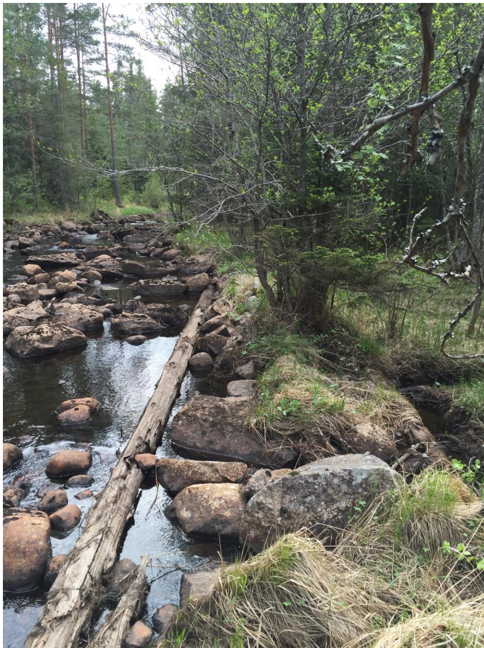
Figur 30. På bilden syns en ledarm som "skärmar av" delar av vattendraget för att leda timret rätt i älvfåran. Foto: Ellinor Forssell, Värmlands Museum.
