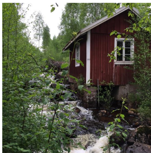
Figur 14. Kraftstationen för fd. Solberga belysningsförening, belägen vid Gröckesälven. Grunden består av pelare som står i älven.
