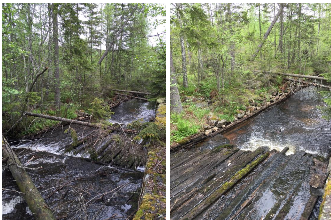
Figur 3. En stötbotten uppförd i två avsatser anträffades vid älven (obj. 16). Denna omgavs av en kilstensmur i sydost och en enkelkista i nordväst (obj.13, 15). Foto: Ellinor Forssell, Värmlands Museum.
