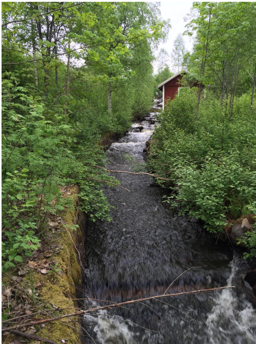
Figur 2. Bild tagen invid kraftstationen i Solberg. Till höger i bild syns en av två tvättstugor som återfinns längs vattendraget. Denna del av älven omges av en kraftig kilstensmur. Foto: Ellinor Forssell, Värmlands Museum.
