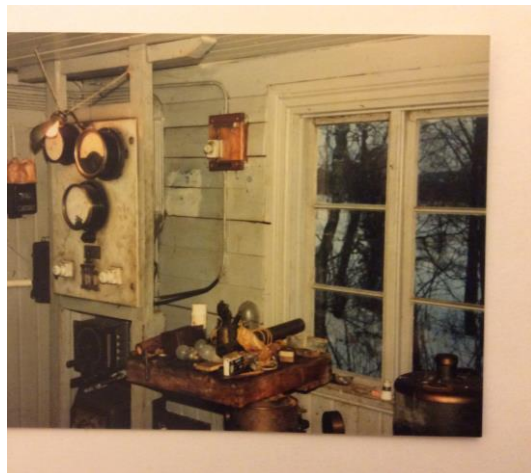
Figur 17. Ovan två fotografier från tidigt 1960-tal på interiören i kraftstationen (fotot ägs av Gunnar och Caisa Åsemark, Solberg Ekshärad).
