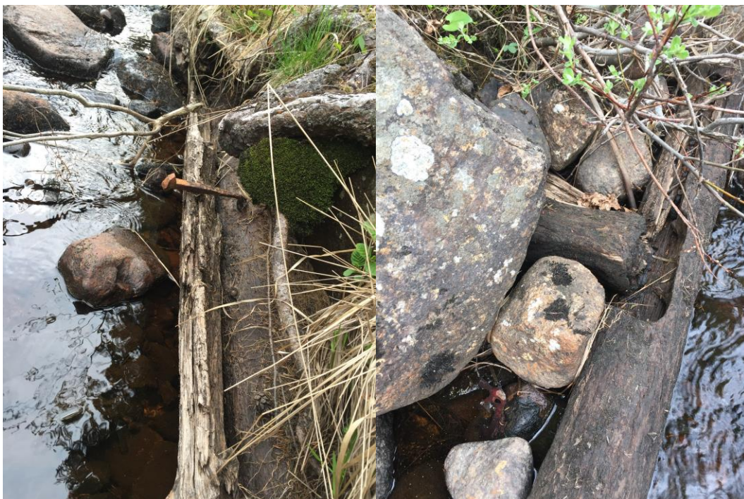
Figur 28. Kistkonstruktionerna har antigen först samman med bettingar av järn eller bettingar av trä. Foto: Ellinor Forssell, Värmlands Museum.
