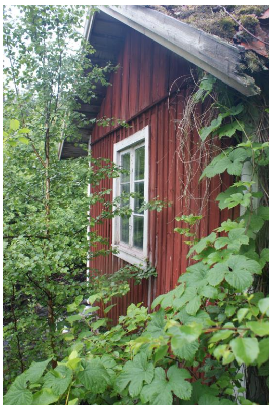
Figur 15. Detaljbild av kraftstationens spröjsade fönster. Nedan syns den ockragula dörren.
