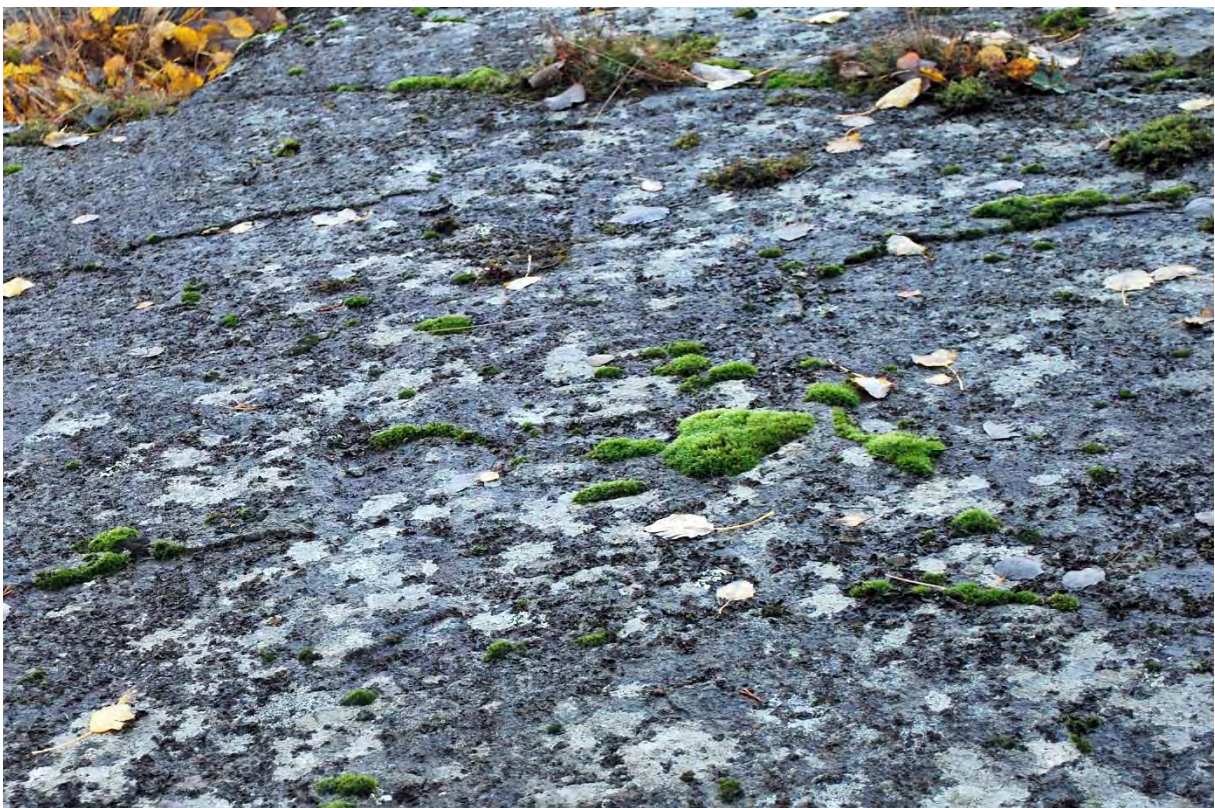
Figur 5: Den andre viktige forvittringsformen, flakforvitring . Her ser vi et eksempel fra Hissingby søndre, som er spesielt sterkt skadet (se forklaringer i vedlegg). (PS)
