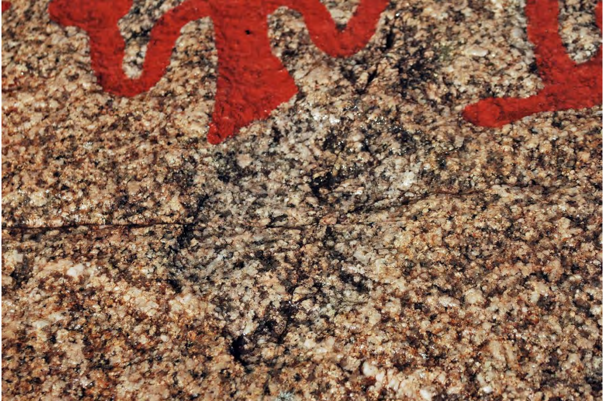
Figur 4: En viktig forvittringsform i granittene, grusforvitring . I dette eksempelet fra Solberg nedre I ser vi at den spesielt er knyttet til riss i bergarten (Ise granitt). Rødfargen er mer intens direkte i overflaten, det skyldes etter alt å dømme rust (jernhydroksider). (PS)
