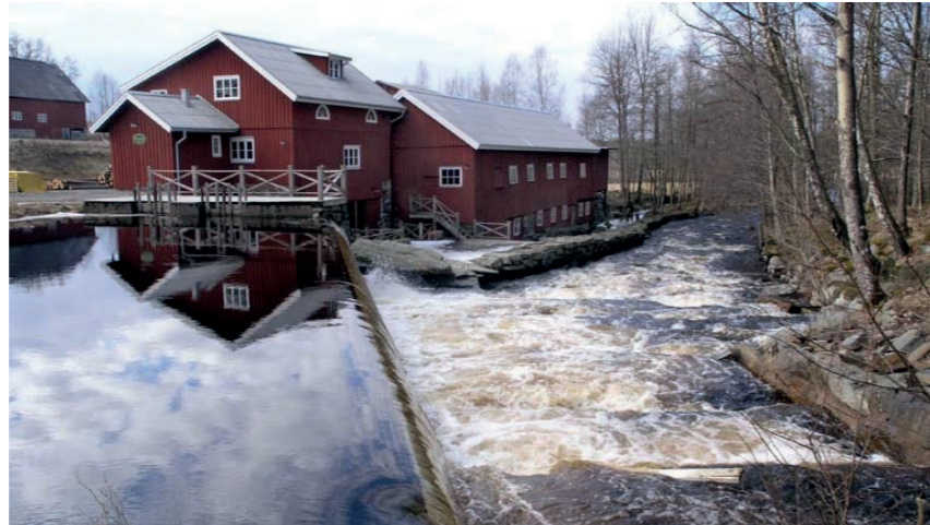
▲ Dammen vid Melltorps kvarn och såg i Hyssna, Västra Götalands län. Foto: Pär Connelid
