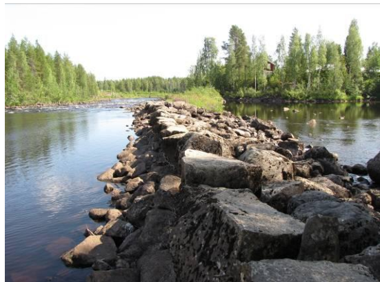
Denna del av Råneälven krävde kraftiga men inte alltid höga ledarmar, som t.ex. anläggningen på bilden (RH 1).
