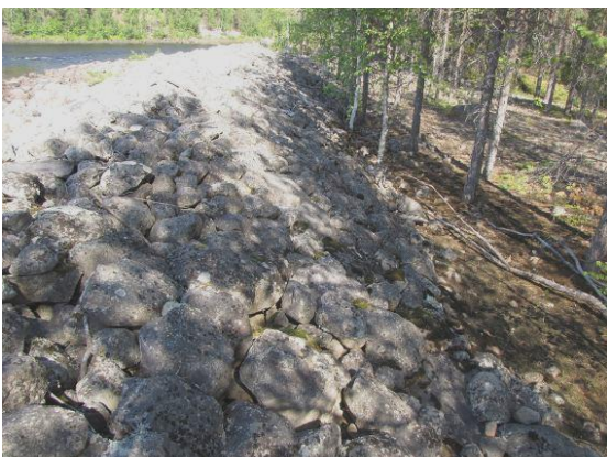
Den största maskinlagda vallen i inventeringen återfinns i Råneälven (RH 3). Den är 7 meter hög vid lågvatten.
