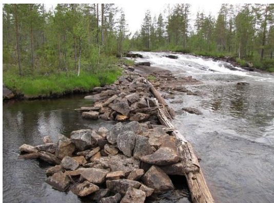
När de övre timmervarven saknas i de enkla trækistorna, rasar stenen ut från karen. Bilden visar ledarmen (LP 2) i Pakkobäcken där något av skärmen står kvar.
