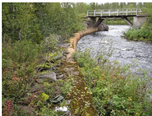
Den gamla timmerkistan i Parkajokis flöde under Korpilombolobron (TOPA 1) har fått en betongklädnad.
