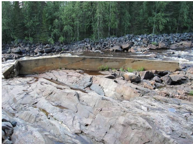
I Skrävån återfinns den enda helt bevarade styrskärmen i betong som påträffats vid inventeringen (KS 13). Rester av en kraftig, dubbel träkista (KS 20) syns under björkarna i fonden.
