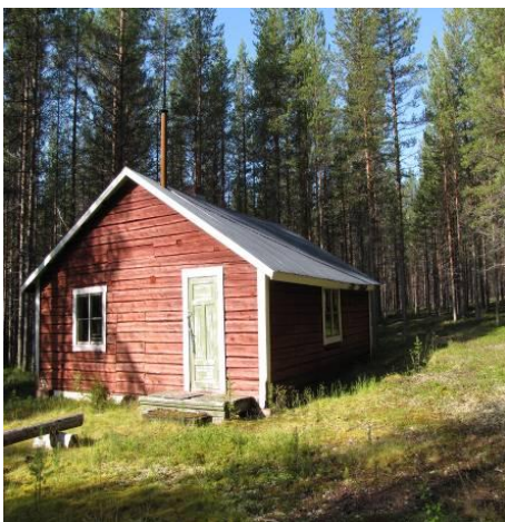
Flottarkojan ligger en bit uppströms led-armarna.
