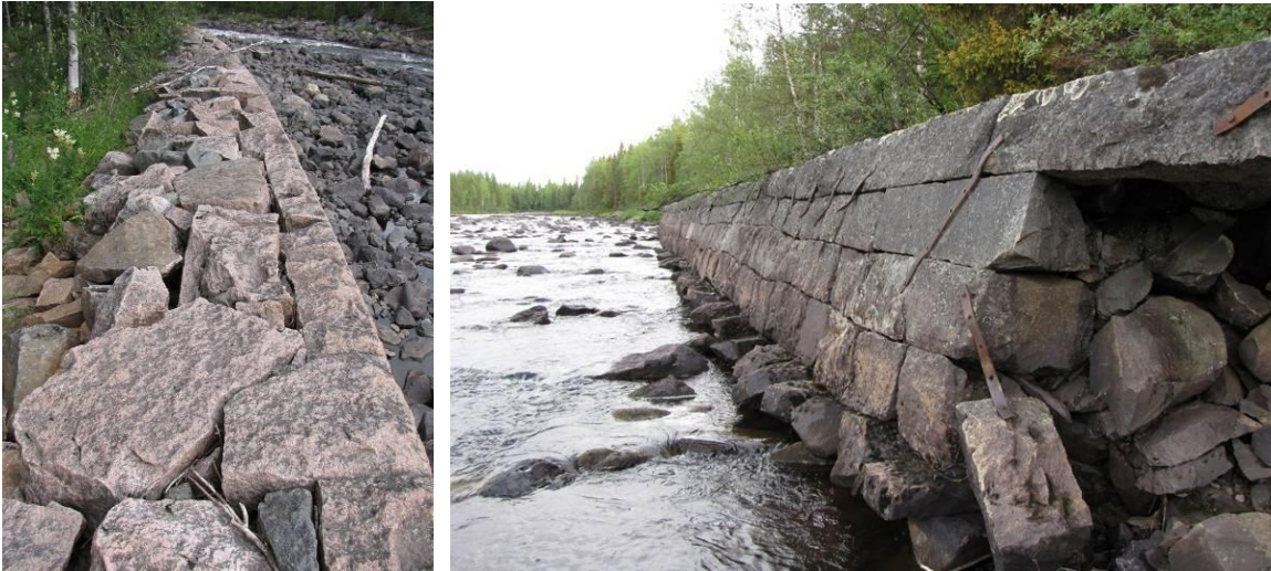
Kilstensmurar (RH 16 och RH 25) i Råneälvens huvudvattendrag. Vid lågvatten syns det underliggande fundamentet.
