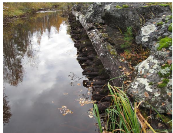
Vid lågvatten framträder risbotten tydligt på Ka 30. Där kistan gett efter har den förstärkts med bult i virket och en wire.
