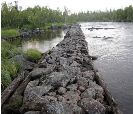
Där de dubbla trækistorna ligger längs med vattenflödet har stenpackningen kunnat ligga kvar trots att de översta stockvarven försvunnit.
