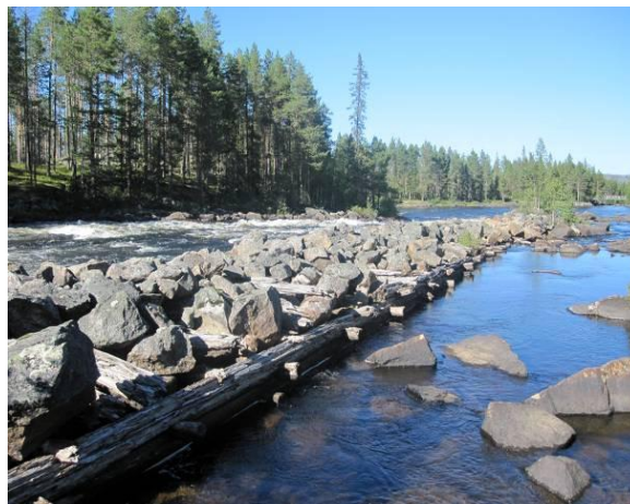
Stabiliteten stärktes genom tätt liggande tvärslår. På bägge bilderna visas dubbla trækistor som återfinns i Pärälven, LP 71 till vänster och LP 24 ovan.
