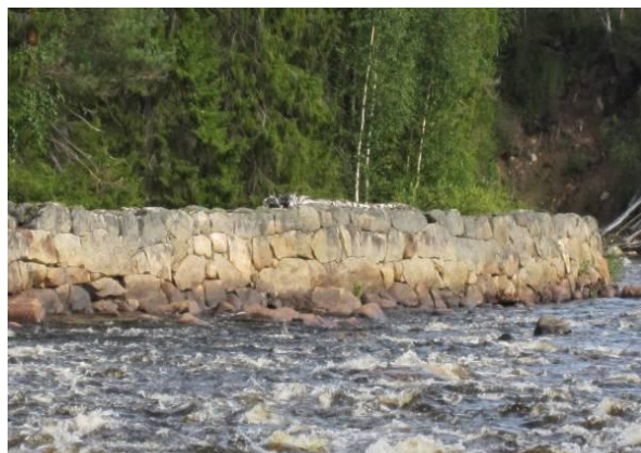
Här syns en mycket vällagd vildstens-/stenkista av Natursten. (KT 7) i Tvärån, Kalix älv. I tekniskt utförande ska den inte förväxlas med kilstensmuren.
