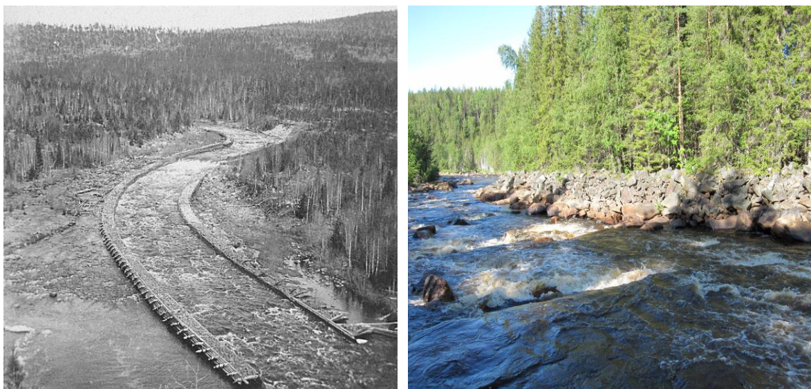
Till vänster syns Skrövfallet innan maskinrensningarna utförts. På vänster sida löper den stora dubbla träkistan, vars rester registrerats som KS 20. I dag återstår endast tvärgående bettingar i stenpackningen. Den högra ledarmen avslutas med en enkel träkista, resterna betecknas KS 14 och KS 18. Fotot från 1900-talets början tillhör www.kalixalvdal.se arkiv.
