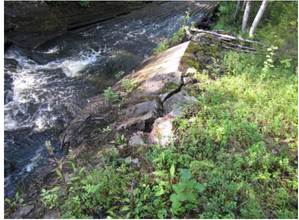
Strandskoningen högre upp har förstärkts med betong.
