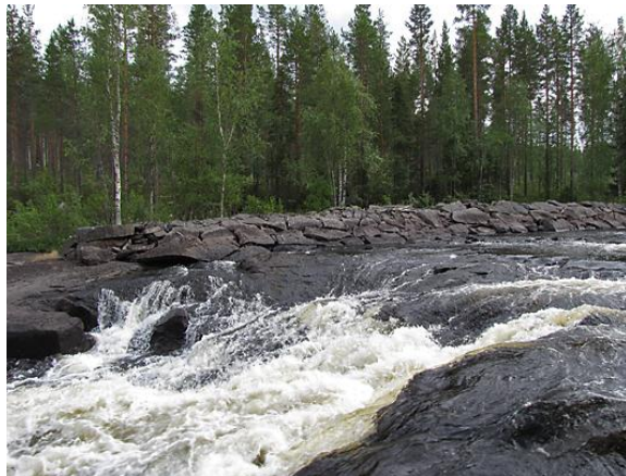
En väl lagd stenslänt i Viståns utlopp mot Piteälven, belägen på högra sidan av Vistån.
