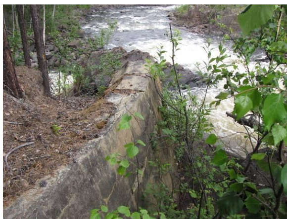
I Vistån, ut mot Piteälven återfinns en ledarm i betong (PV 5) som går ut på klippan i ån nedanför.
