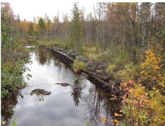
Vid lågvatten framträder risbotten tydligt på Ka 30. Där kistan gett efter har den förstärkts med bult i virket och en wire.
