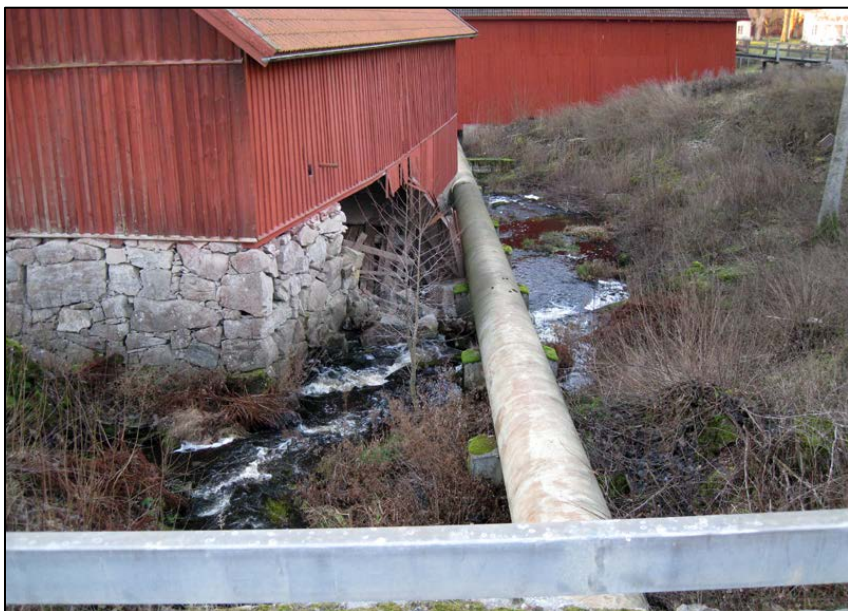
Turbinröret till kraftverket.
