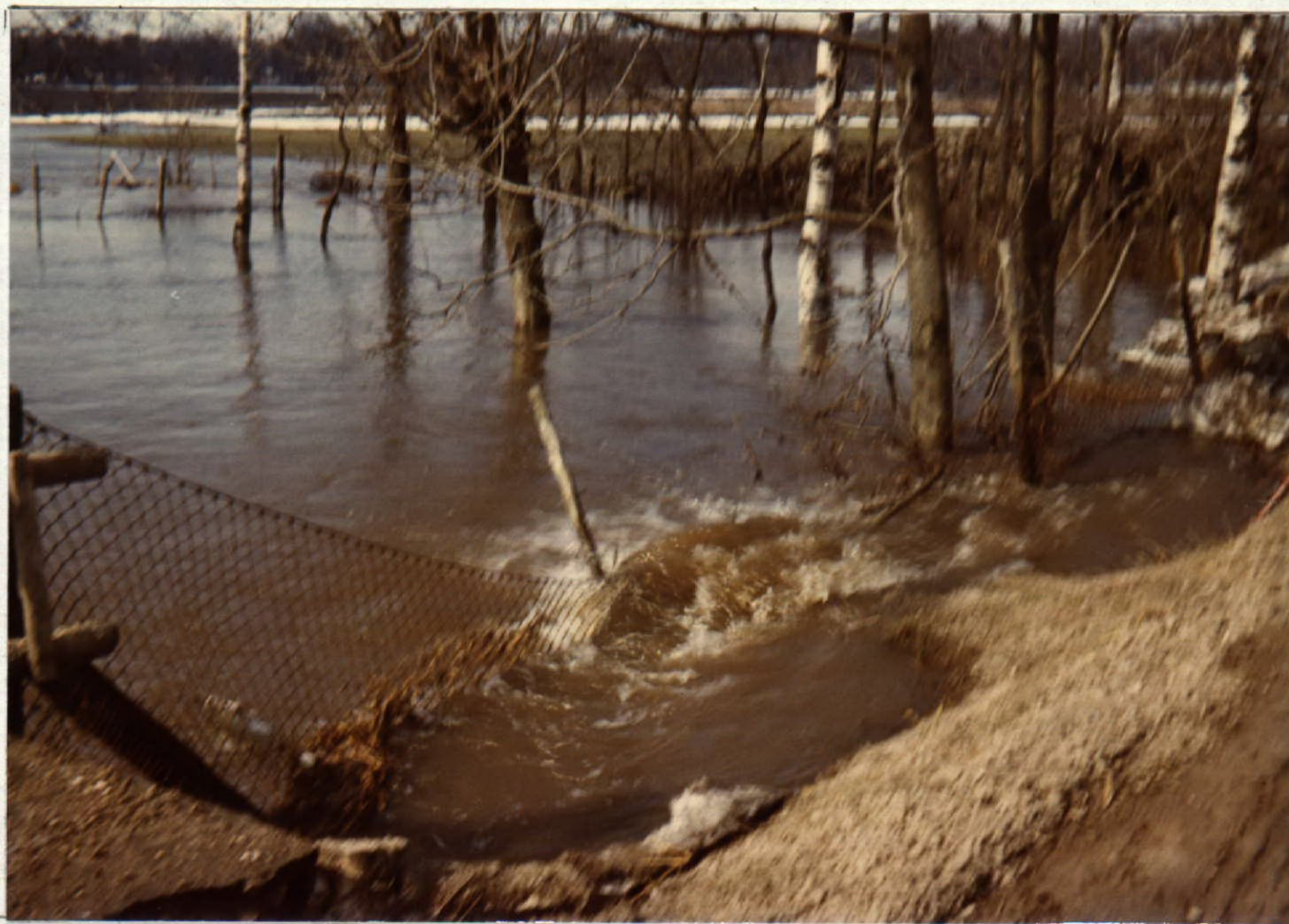
Nedströmsvy tagen vid vägtrummans utlopp (sektion 12+05).
