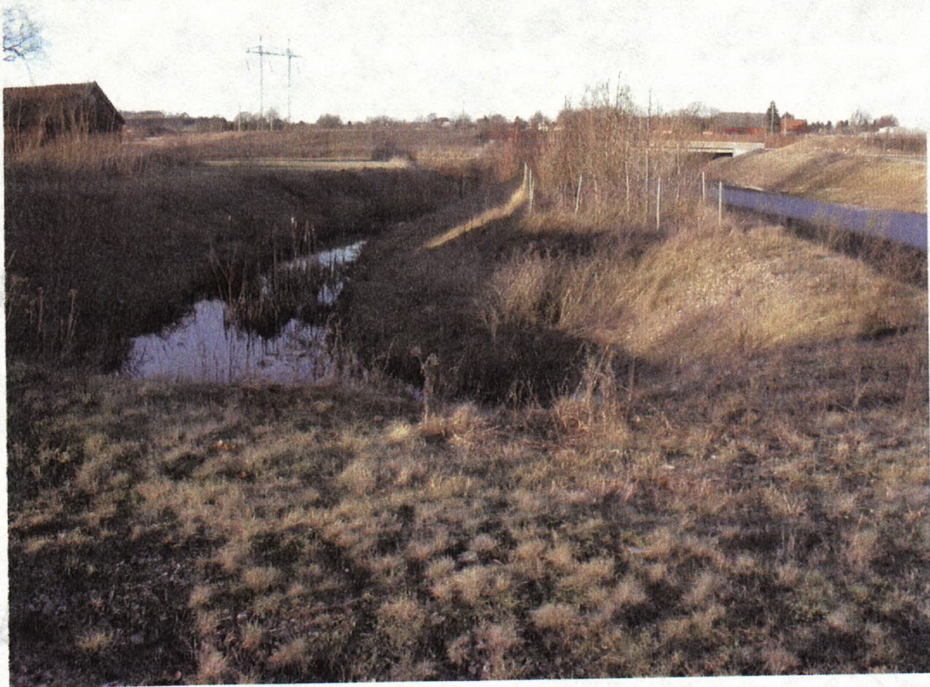
Bild 2. Vy åt norr. Marknivån behöver sänkas på vallen mellan väg och dike för att underlätta framkomlighet.
