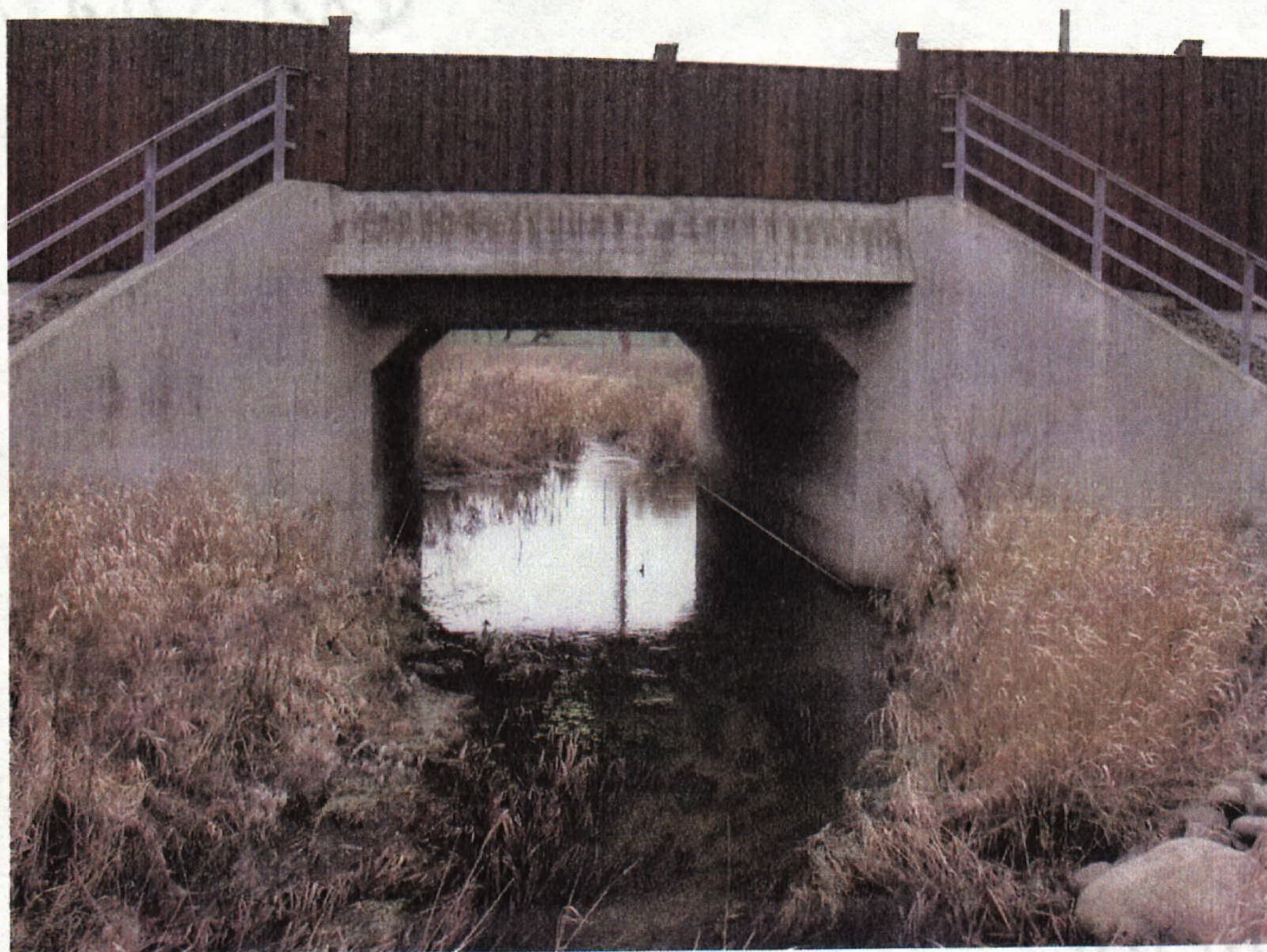
Bild 2. Järnvägsbron från nedströmssidan. Simons åra ansluter från höger. Med föreslagen kulvertering kommer man åt att rensa i broläget.
